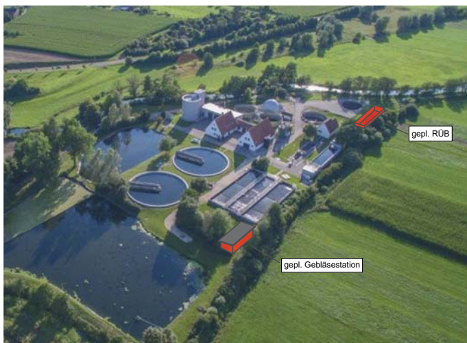
Die Planungen für die kommenden Jahre an der Sammelkläranlage des Abwasserzweckverbands Härtsfeld bei Dattenhausen
