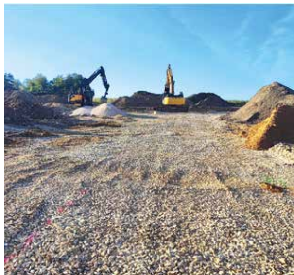
Die Erschließung des Gewerbegebiets „Im Reichertstal IV“ in Elchingen.
