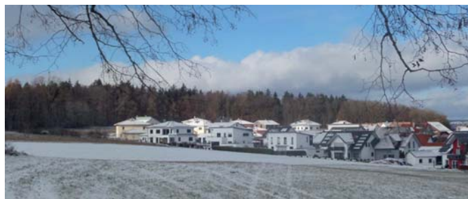
Baugebiet „Bennenberg“ in Ohmenheim, nahezu vollständig bebaut.
