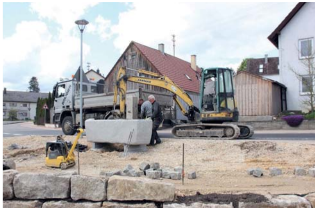
Beim Einbau des Brunnens an der neuen Grünanlage.
