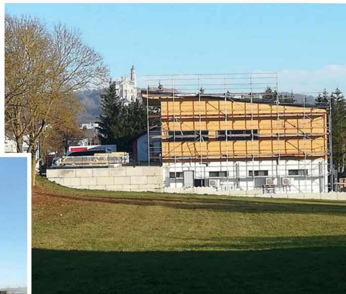
Bauvorhaben zum Neubau eines Metzgereiladengeschäftes an der Heidenheimer Straße.
