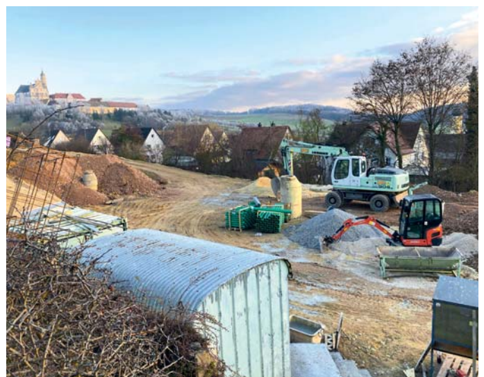
Die Großbaustelle der Samariterstiftung am Sohl.
