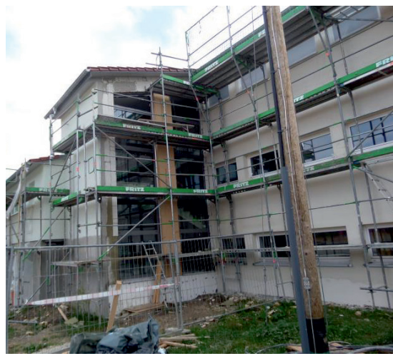
Baufortschritt im Oktober
