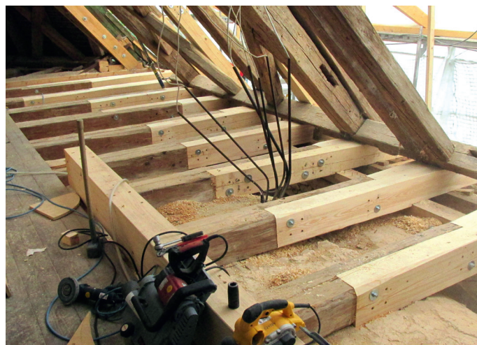
Das Gebälk wurde nach alter Zimmermannskunst aufwändig saniert.
