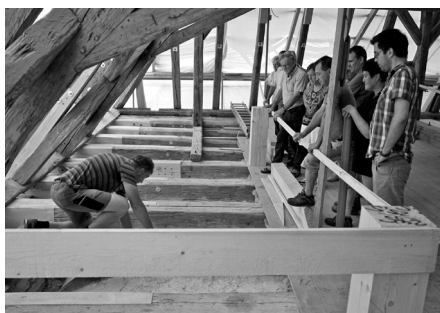
Besichtigung der Sanierungsarbeiten im Dachstuhl der Pfarrkirche Elchingen.
