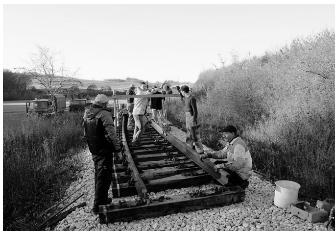
Beim Gleisbau im Egaual Richtung Härtsfeldsee.
