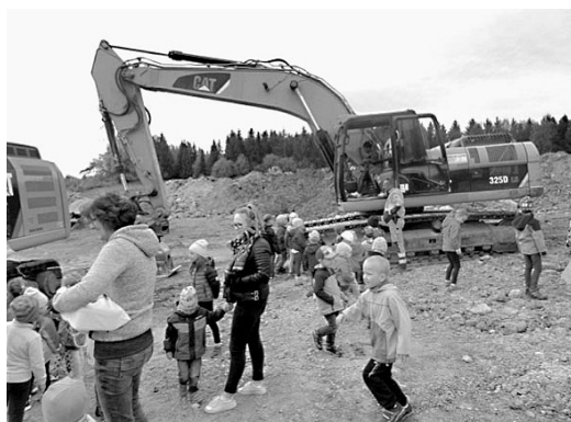
Groß war die Freude der Kindergartenkinder der städtischen Kita Ohmenheim beim Besuch der Baustelle im Baugebiet „Bennenberg West“.
