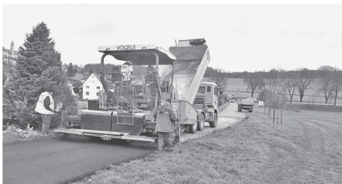
Asphaltierungsarbeiten u. a. an der Gallusmühle.
