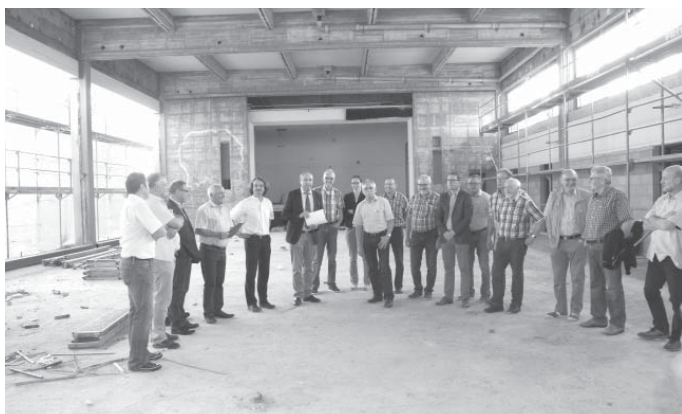
Architekt Tröster (5. v. l.) erläutert dem Gemeinderat und Bürgermeister Dannenmann (6. v. l.) den Baufortschritt bei der Generalsanierung der Härtsfeldhalle.
