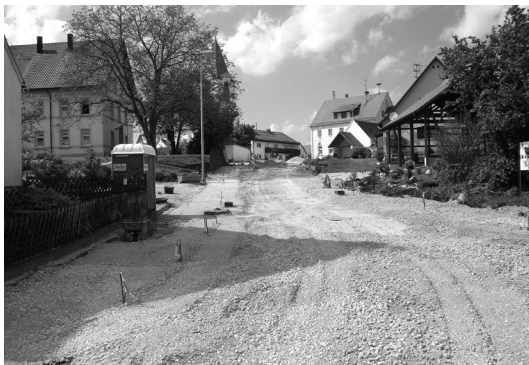
Herstellung des Straßenunterbaus in der Kirchstraße.
