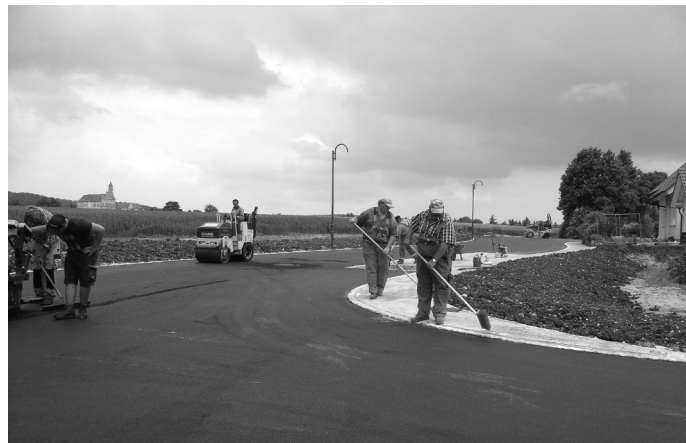
Fertigstellung des Asphaltbelages.
