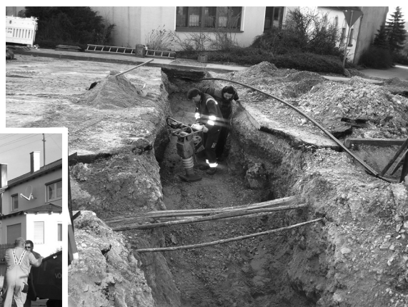
Die Erneuerung der Hausanschlüsse verursachte einen hohen Aufwand, da teilweise Fels angetroffen wurde.
