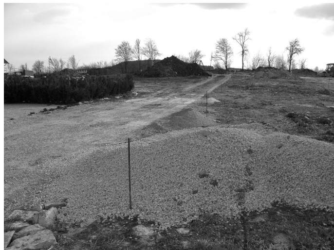
Beginn der Erschließungsmaßnahme.
