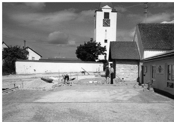
Pflasterarbeiten in der Dorfmitte (rechts Feuerwehrgebäude).
