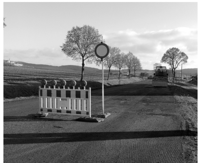
Der sanierte Abschnitt der L 1084 kurz vor der Freigabe für den Verkehr.
