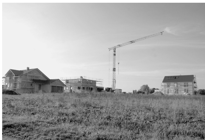
Das Baugebiet „Großkuchener Weg Nord“ in Elchingen.
