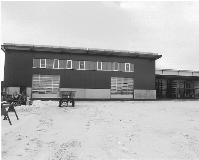
Die neue Fertigungshalle der Fa. Zeyer.
