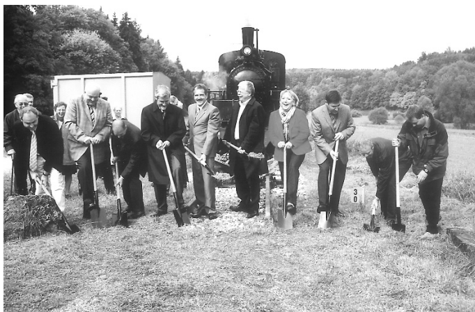
Viel „Prominenz“ gab sich beim Spatenstich zum Weiterbau der Museumsbahn die Ehre.
