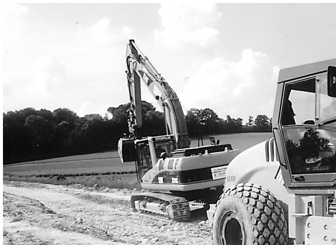
Über 6 Monate dauerten die Bauarbeiten an der L 2033.
