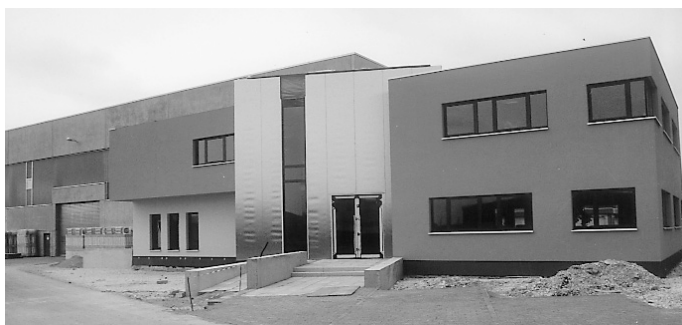
Das neue Bürogebäude der Fa. ADK.
