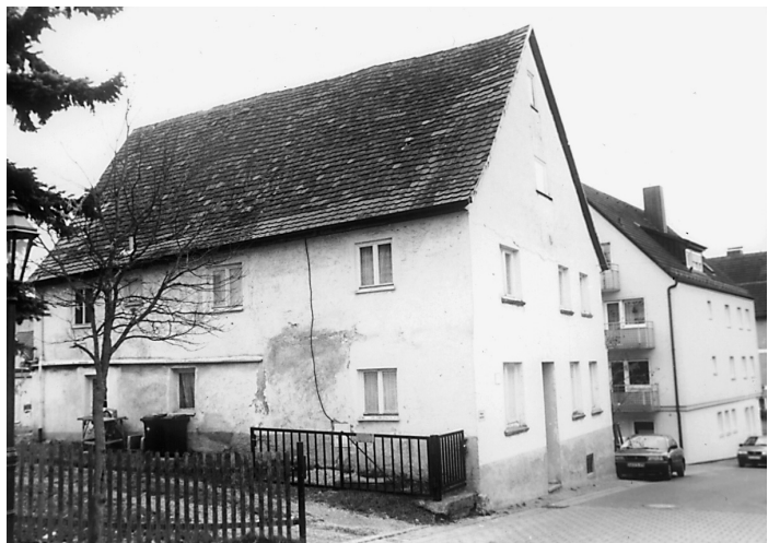
Das Gebäude Storchengasse 4 wurde ebenso abgerissen...
