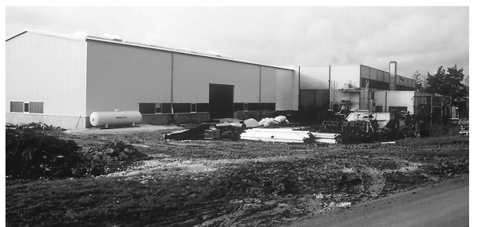
Noch zum Jahresende konnte die neue Fertigungshalle der Fa. Kinzler bei Stetten fertiggestellt werden.
