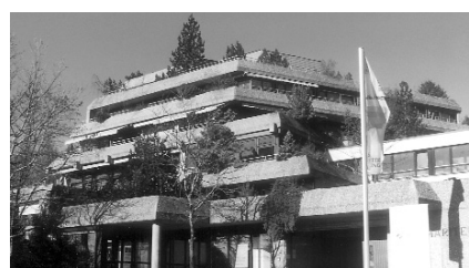
Das bisherige Altenpflegeheim kann nach Auskunft des Samariterstifts nicht mehr saniert werden. Es soll durch einen Neubau am Fuße des Ulrichsbergs ersetzt werden.
