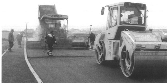
Kurz vor Wintereinbruch erfolgte die Aufbringung des Bitumenbelags, so dass das Gewerbegebiet „Im Riegel“ jetzt von zwei Seiten, abgehend von der L 1084, erschlossen ist.
