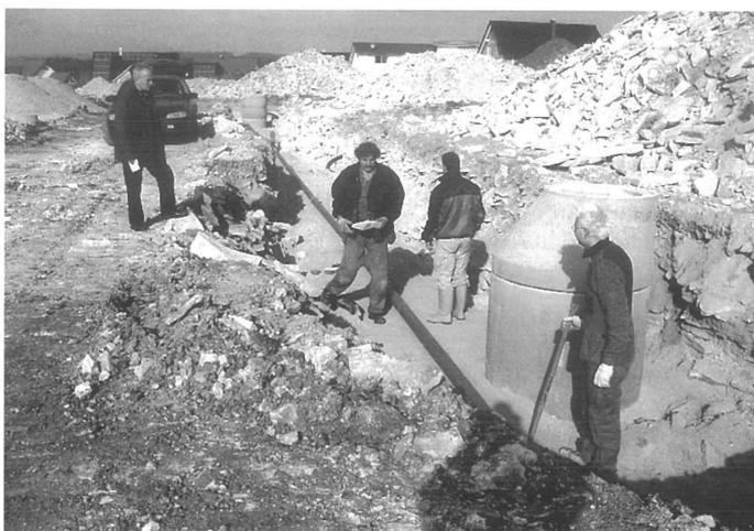
Zügig gehen die Erschließungsarbeiten am restlichen Teilstück des Dossinger Weges voran. Kanal-, Wasserleitung und die Schottertragschicht konnten noch rechtzeitig vor der kalten Witterung eingebracht werden. Durch diese weitere Erschließungsmaßnahme werden 9 Bauplätze erschlossen, wovon erfreulicherweise bereits vor Jahresende 6 Bauplätze verkauft werden konnten. Die Fertigstellung der Baumaßnahme ist bis Ende April 2006 vorgesehen.
