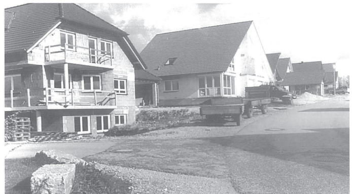
Auch 2002 wurden im Baugebiet „Sohlhöhe“ in Neresheim neue Wohnhäuser errichtet.
