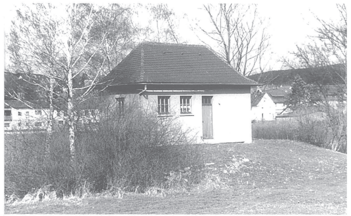
Pumpstation am „Faulen Eck“.
