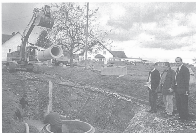
Einbau des 1. Kanalrohres: Stadtbaumeister Weber, Ortsvorsteher Leberle und Bürgermeister Dannemann.
