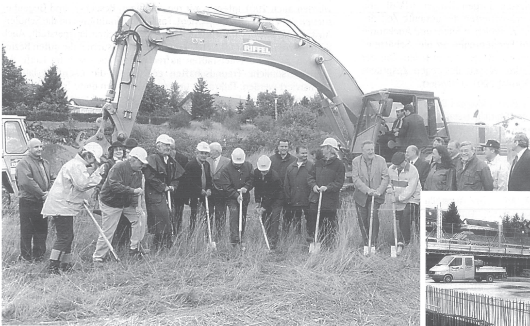
1. Spatenstich bzw. 1. Baggerbiss zum Bau der Dreifachsporthalle.
