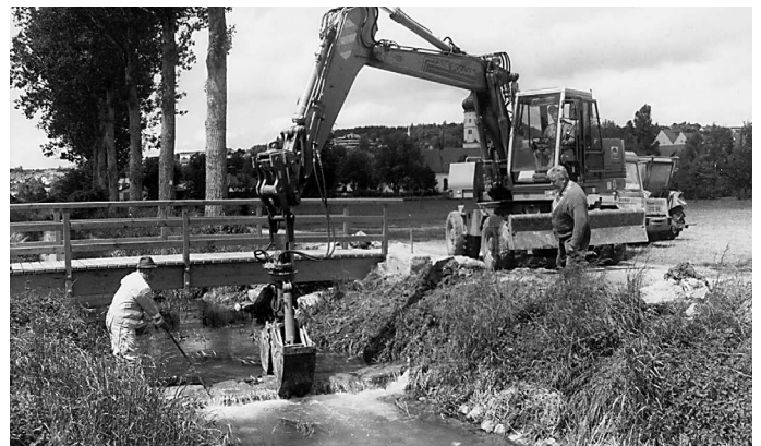
Mit der neuen Brücke über die Egau wurde der sog. „Judengumpen“ begehbar gemacht.
