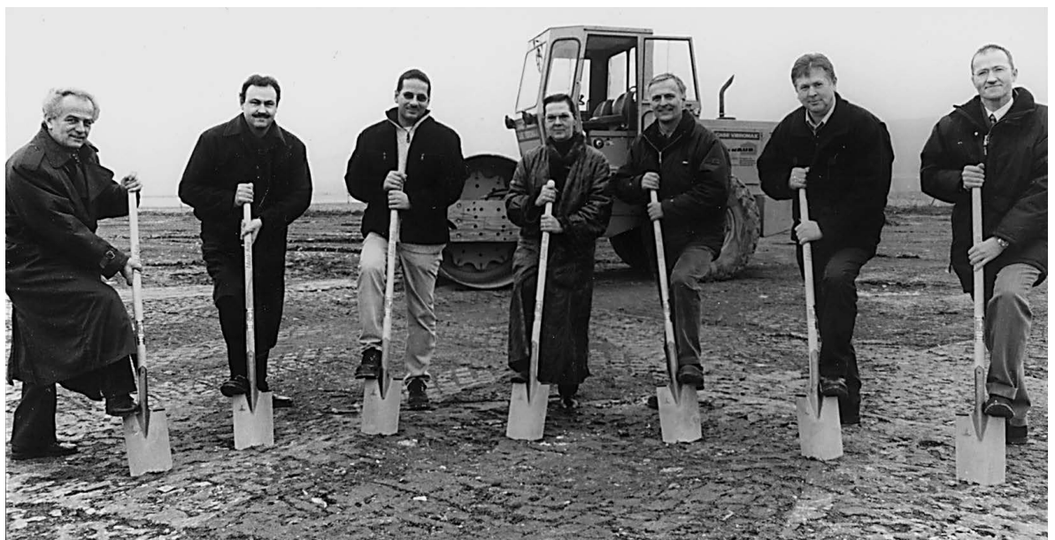
1. Spatenstich zum Bau einer Lagerhalle mit Baumarkt der Fa. Karl Schnepf GmbH. In der Bildmitte Firmeninhaberin Gerda Wohlgenannt.
