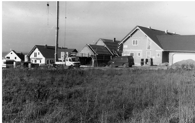
Rege war die Bautätigkeit im Baugebiet „Sohlhöhe“ in Neresheim.
