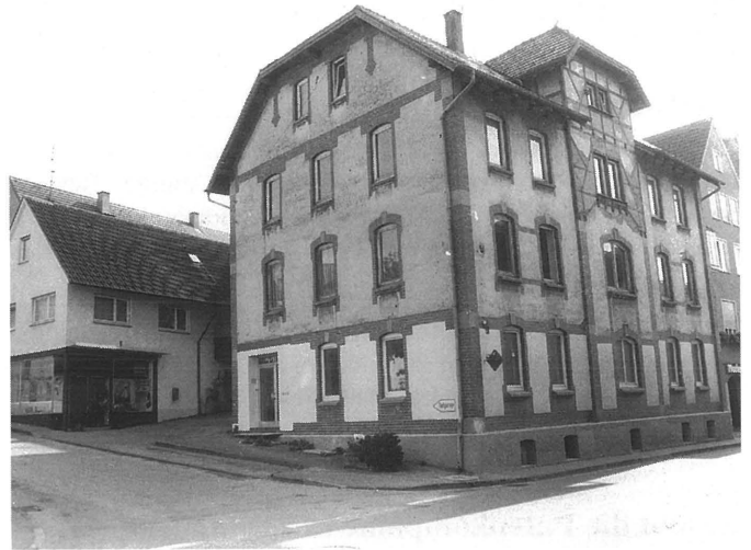
Bereits heute ein „historisches“ Foto; die Gebäude Hauptstraße 32 und Obere Gasse 19 vor dem Abbruch.
